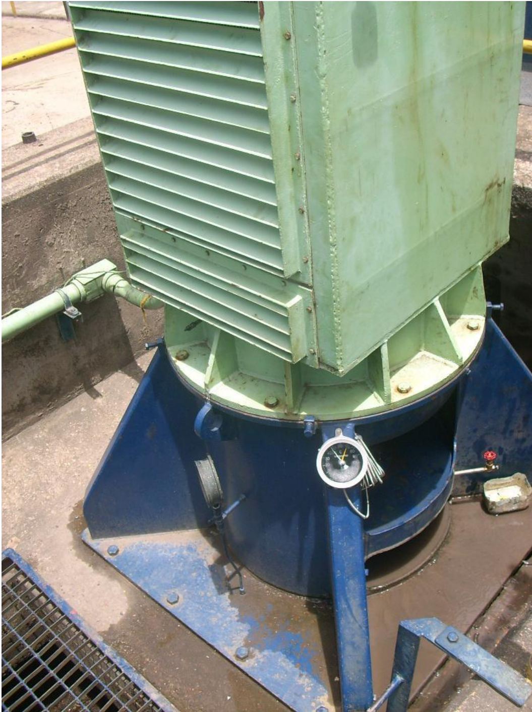
Foto 21. Motor y bomba - Bomba vertical.
