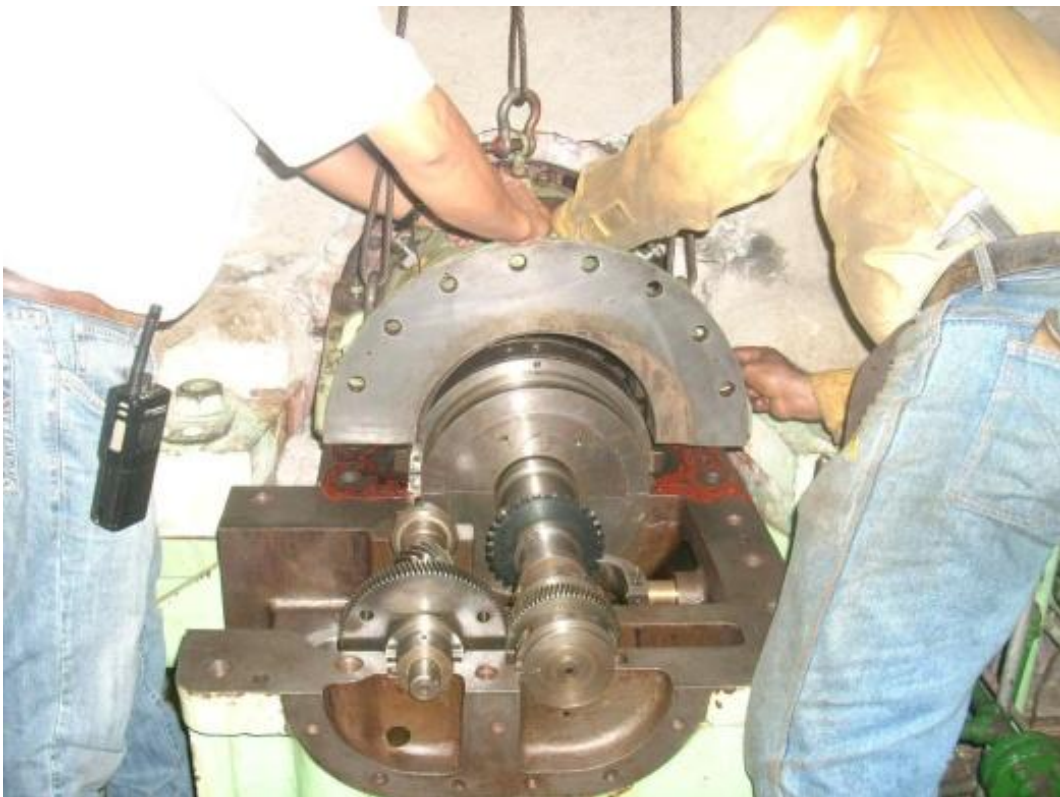
Foto 7. Instalación tapa zona de empuje -Turbina 2.
