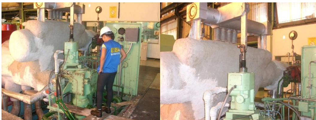
Foto 15. Zona de empuje, cilindro actuador; mando de regulación, válvulas de regulación entrada de vapor -Turbina 2.
