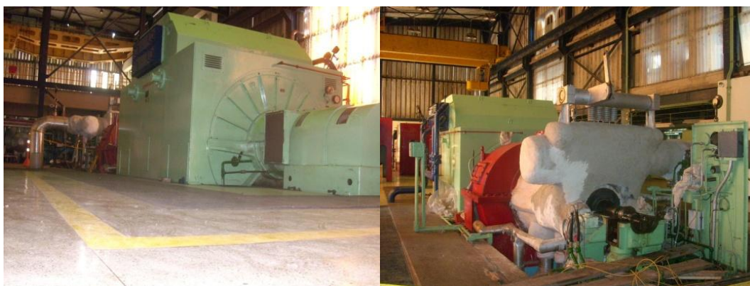
Foto 17. Generador y excitatriz, turbina-Turbina 2.
