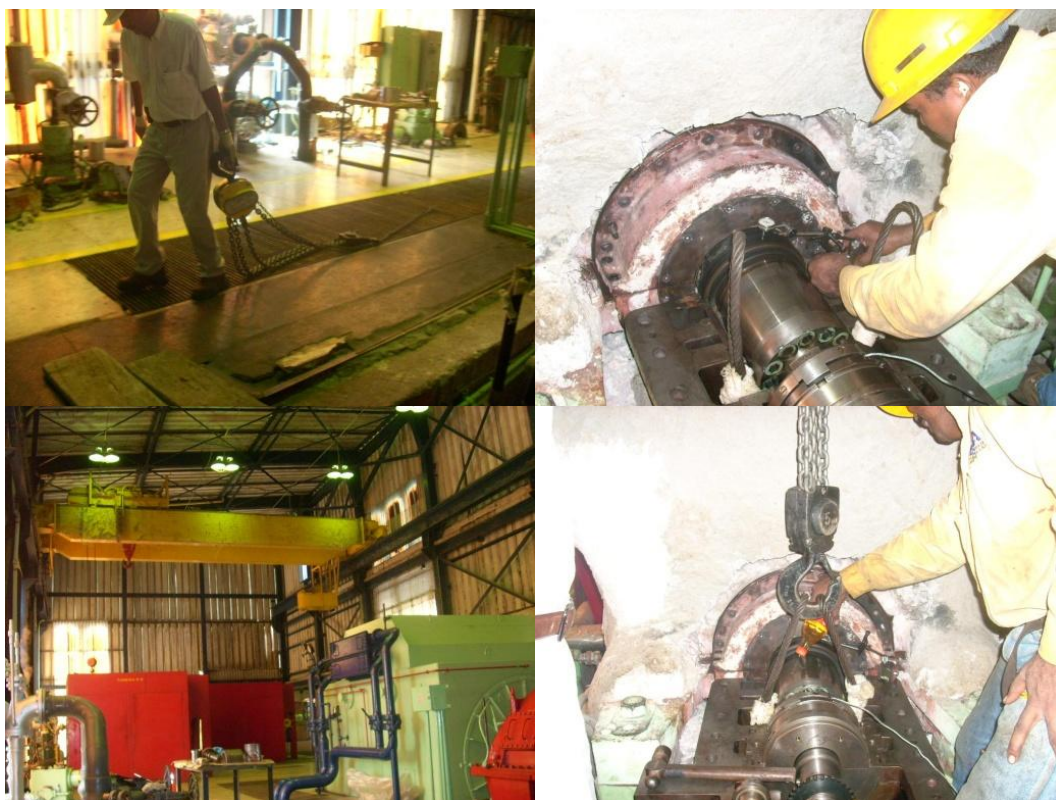
Foto 2. Diferencial de cadena; instalación comparador para levantar eje y medición con indicador de carátula; puente grúa sala de turbinas; elevación del eje – Turbina 2.
